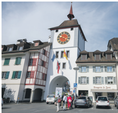
Das 1968 wieder erbaute Unterort von Willisau.
